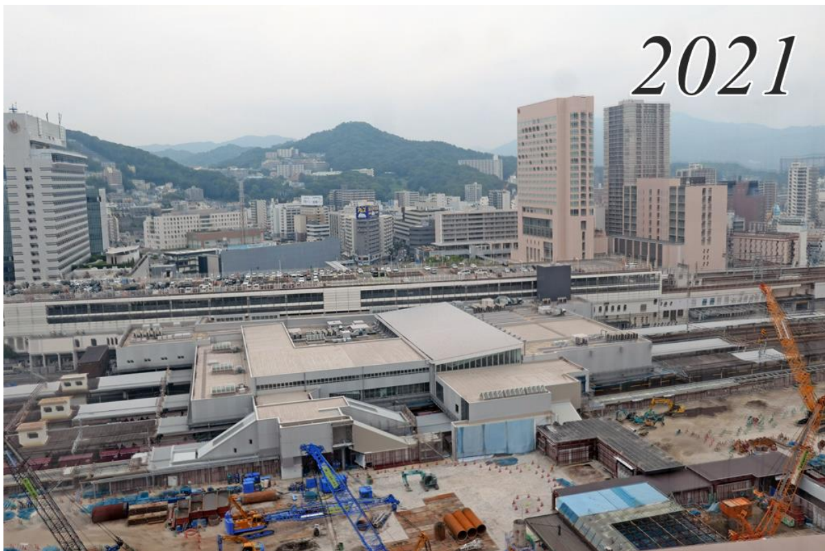
駅ビルの建物がなくなった
