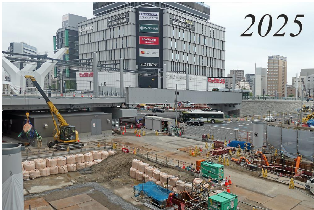
ペDESTリアンデッキ工事が進む
