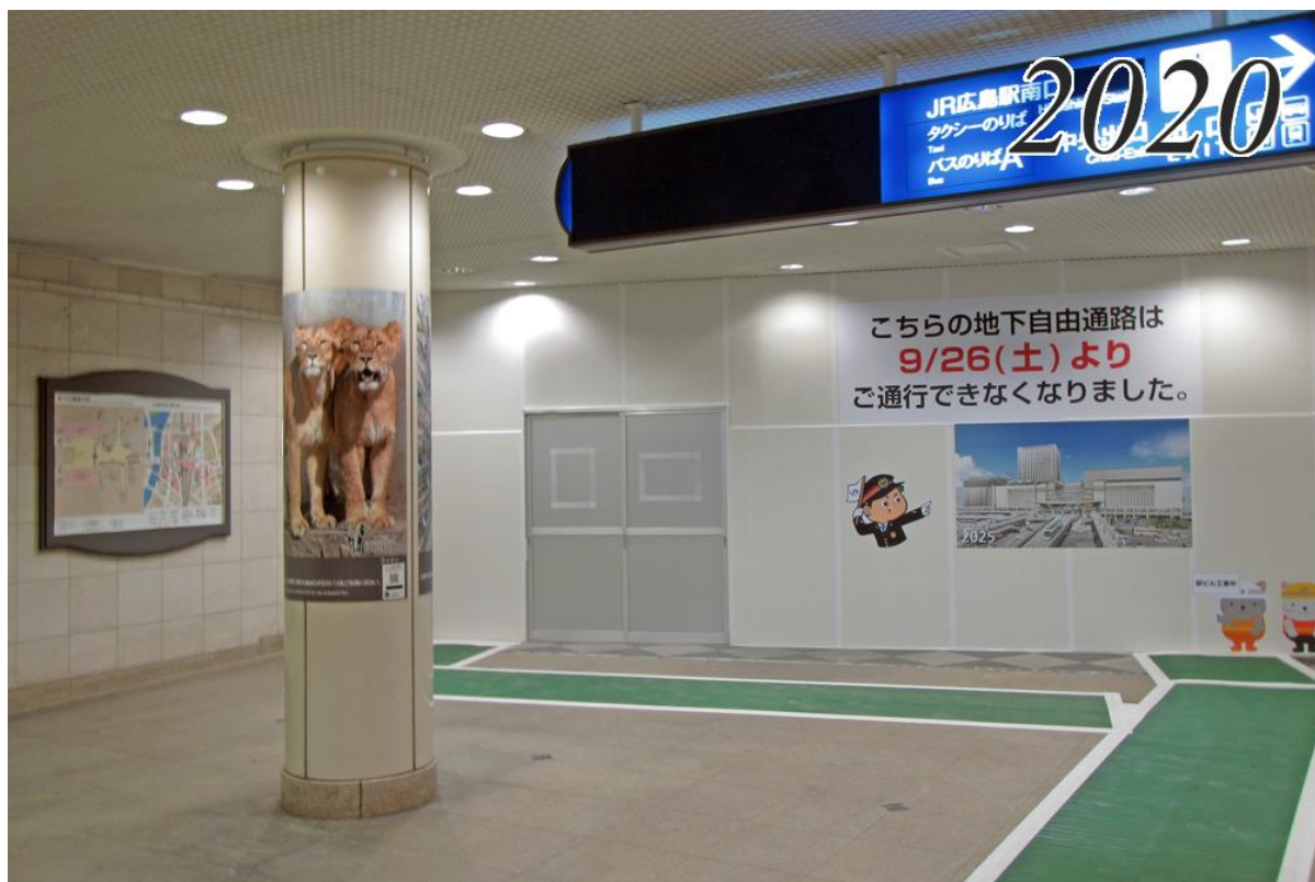
駅の南北を結ぶ地下自由通路が閉鎖された
