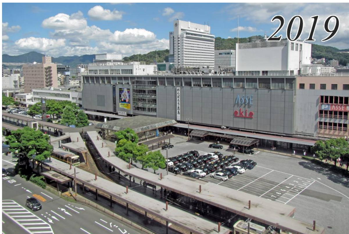
駅ビル「ASSE」全景
