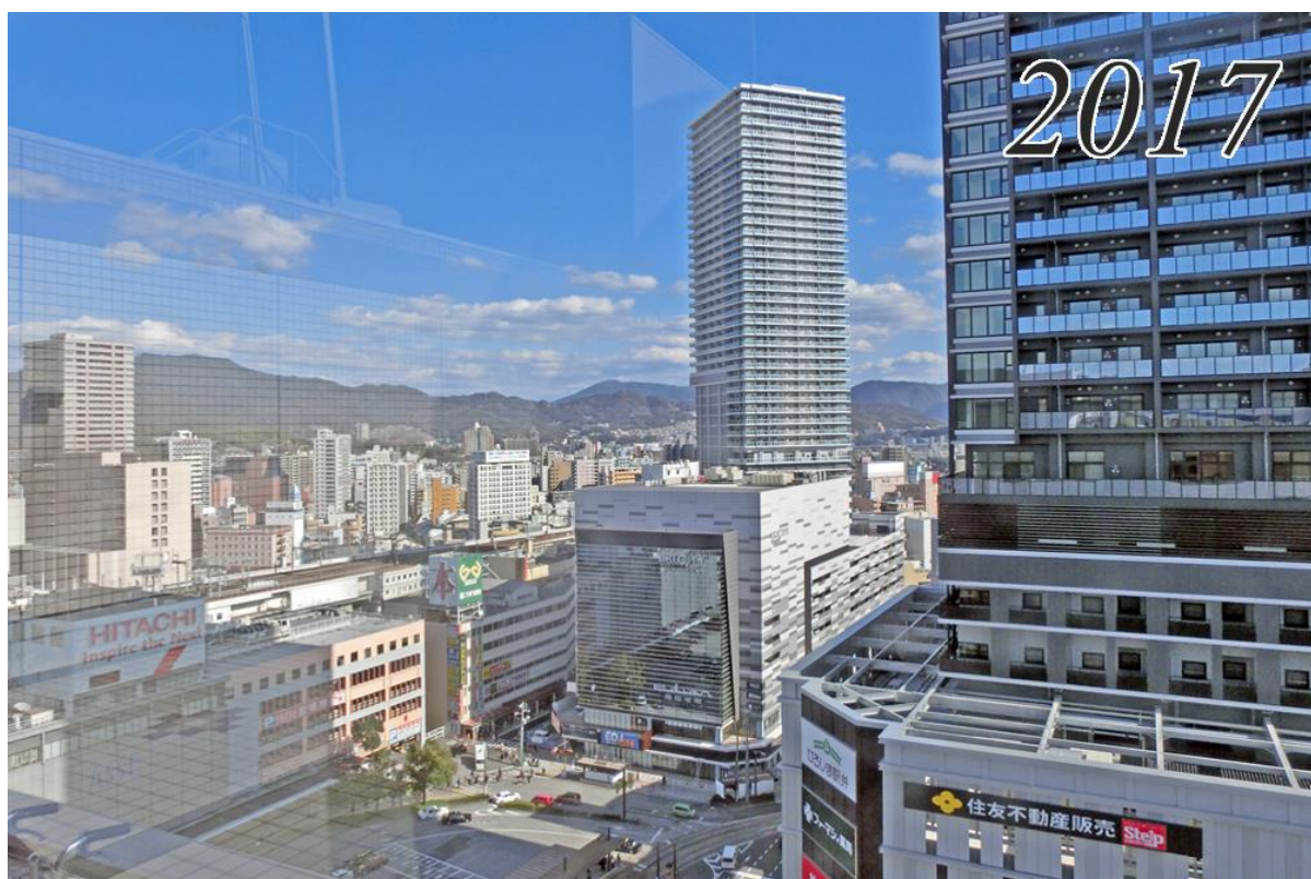
エールエール A 館屋上から再開発B, Cブロック方向を写す
