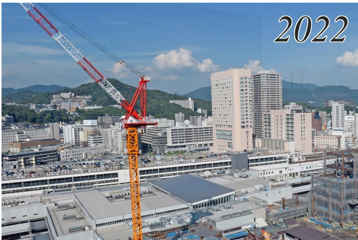
新駅ビルの建築工事が始まった
