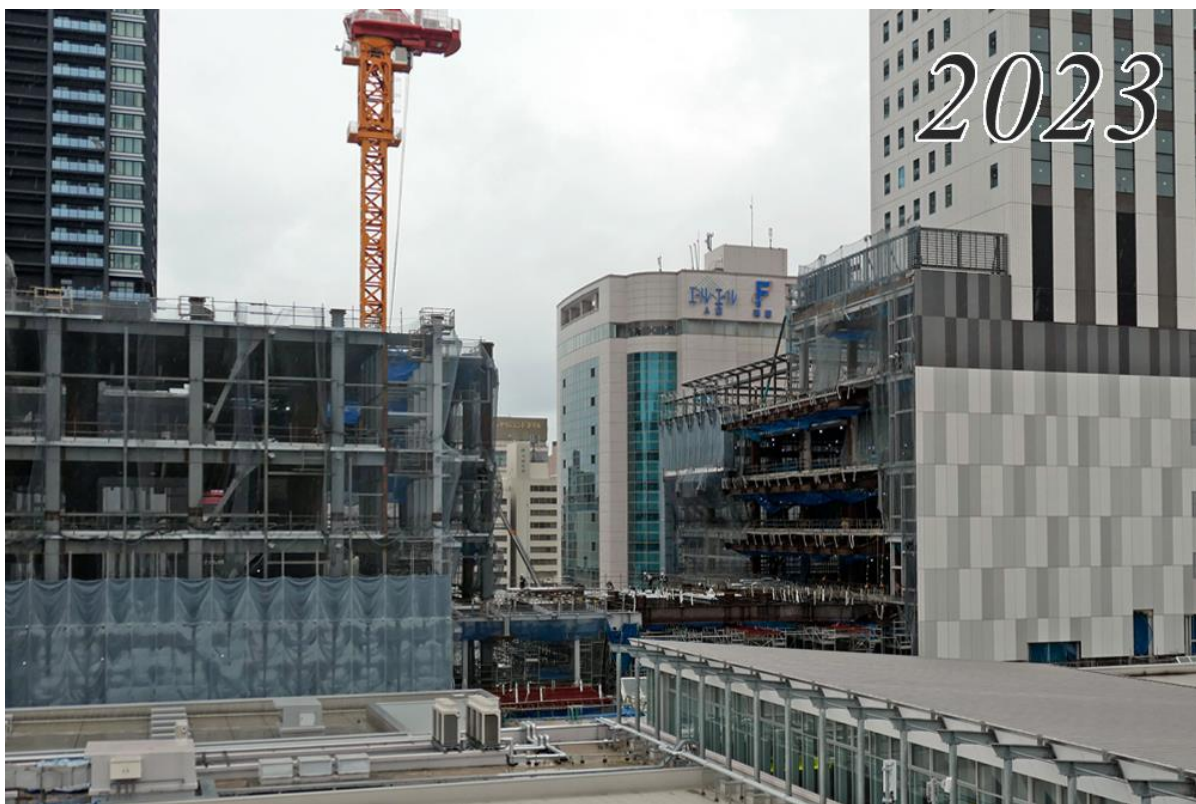
新しい路面電車ホームになる場所を新幹線口屋上駐車場から写す
