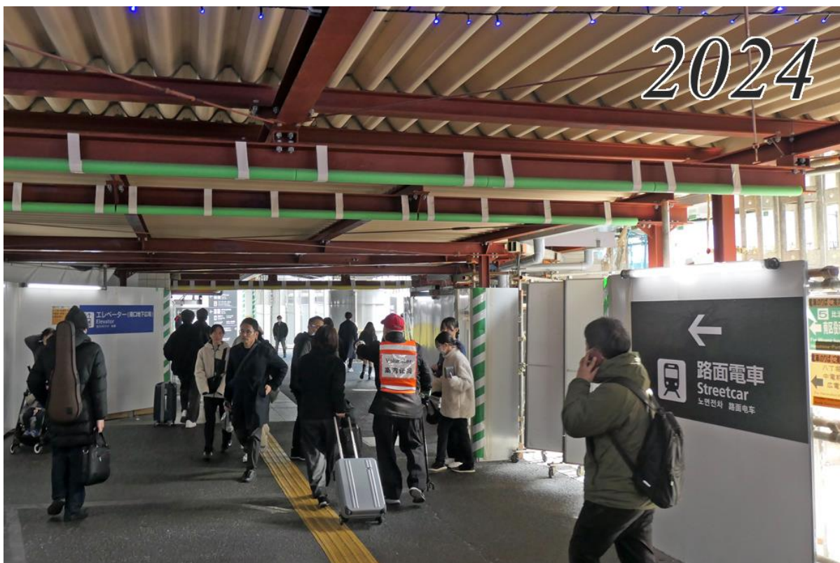
2階にできる路面電車ホームの直下部分
