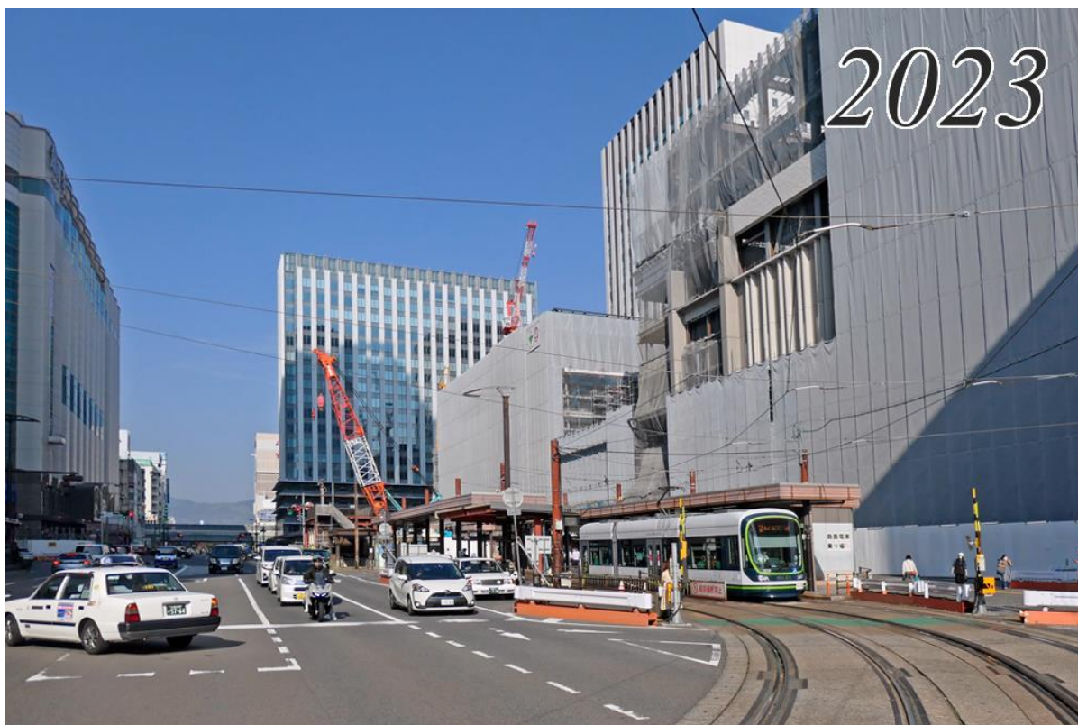
駅ビルの形がだいぶ出来上がっている
