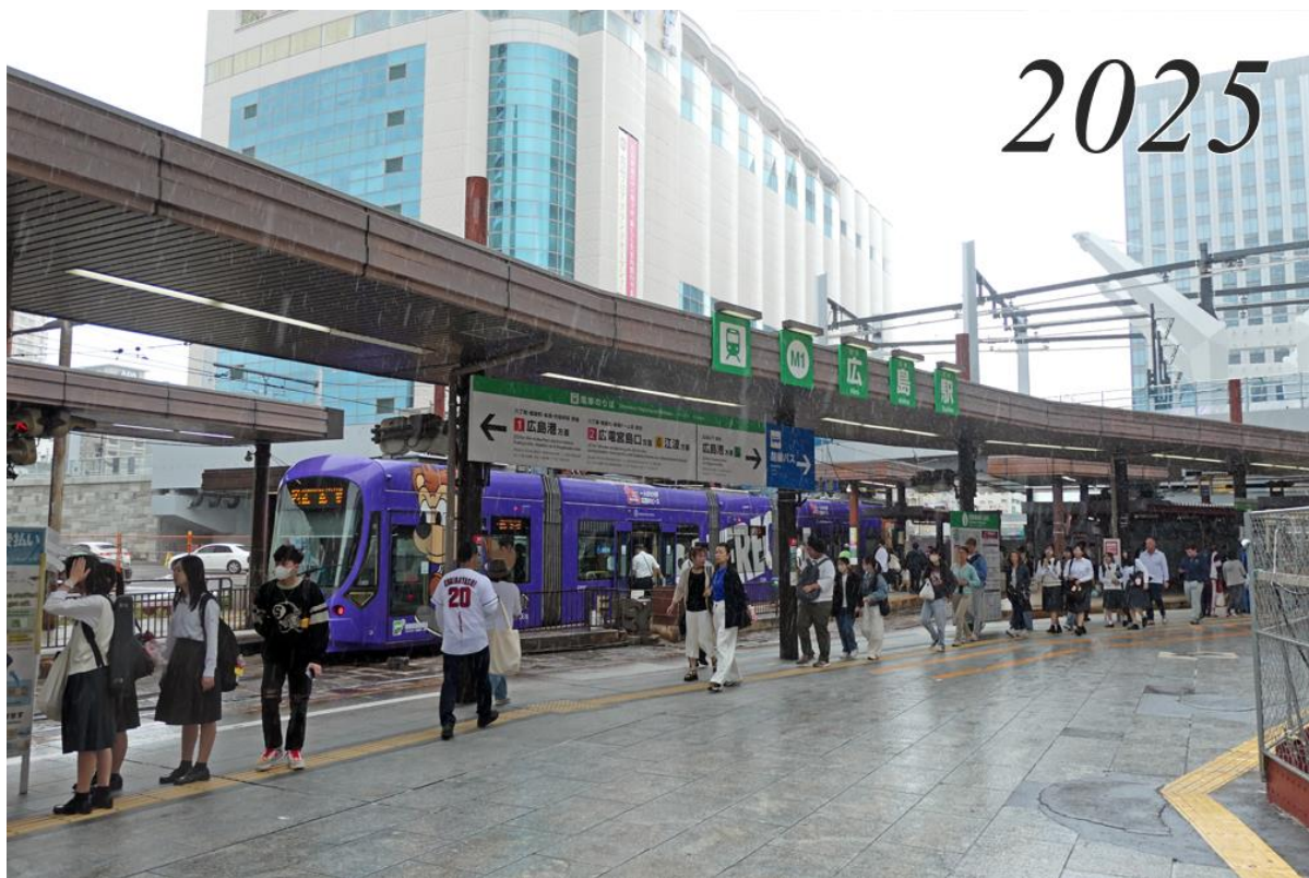
高架の新ルートに架線が張られ始めた
