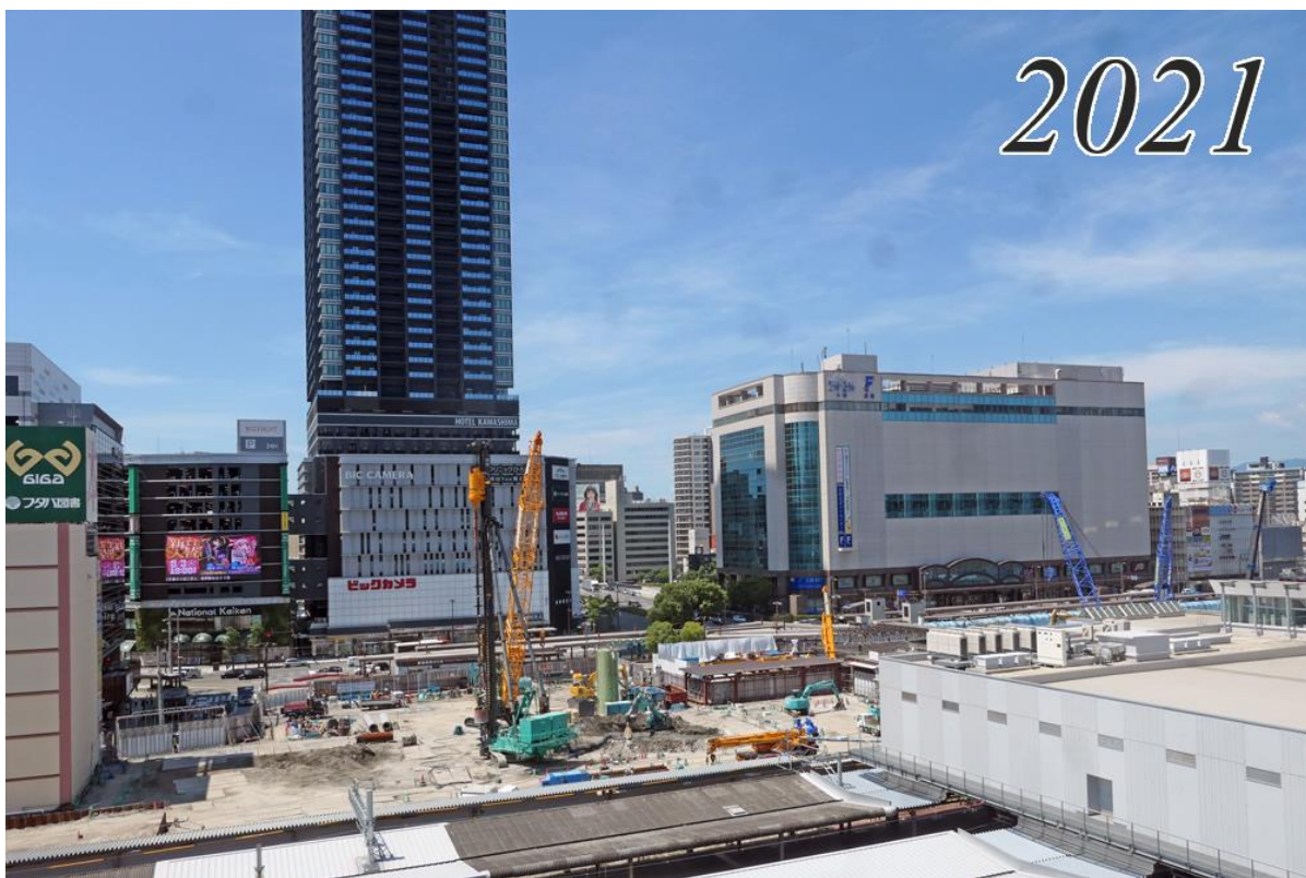
新駅ビルの建築工事が始まった
