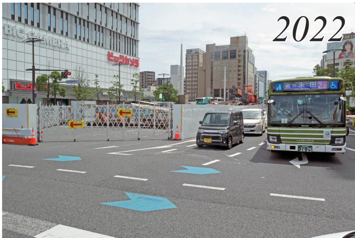
駅前大橋方向を写す
