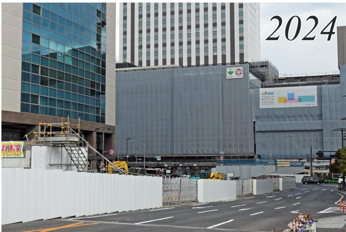
駅ビル2階につながる高架部分の工事が進む
