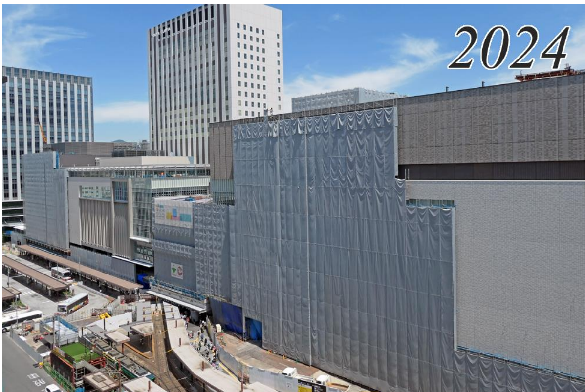
駅ビルが完成に近づく
