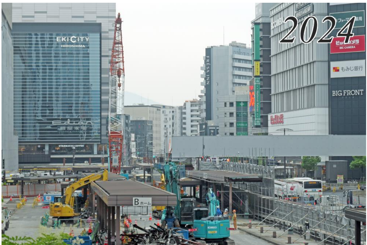
延びてきた橋げたを JP ビルディングから写す
