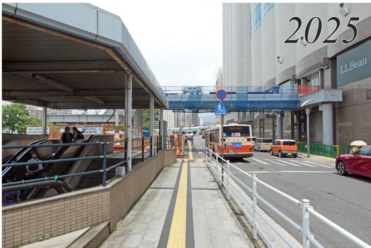
エールエールA館でもペデストリアンデッキ工事が進む
