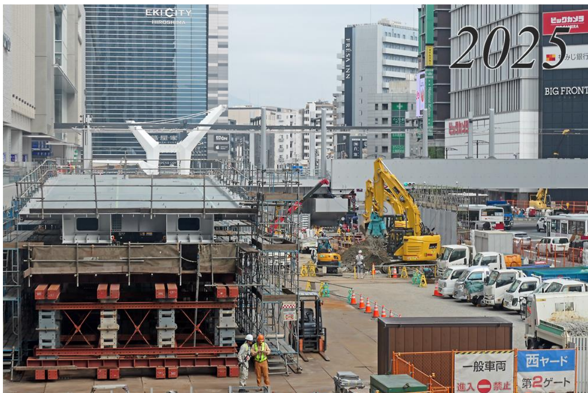
路面電車軌道の西側でペデストリアンデッキ工事が進む
