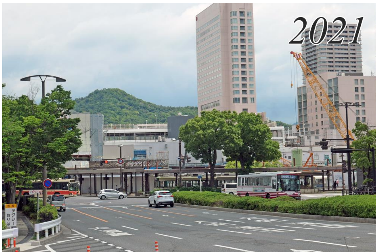
新駅ビルの建築工事が始まった
