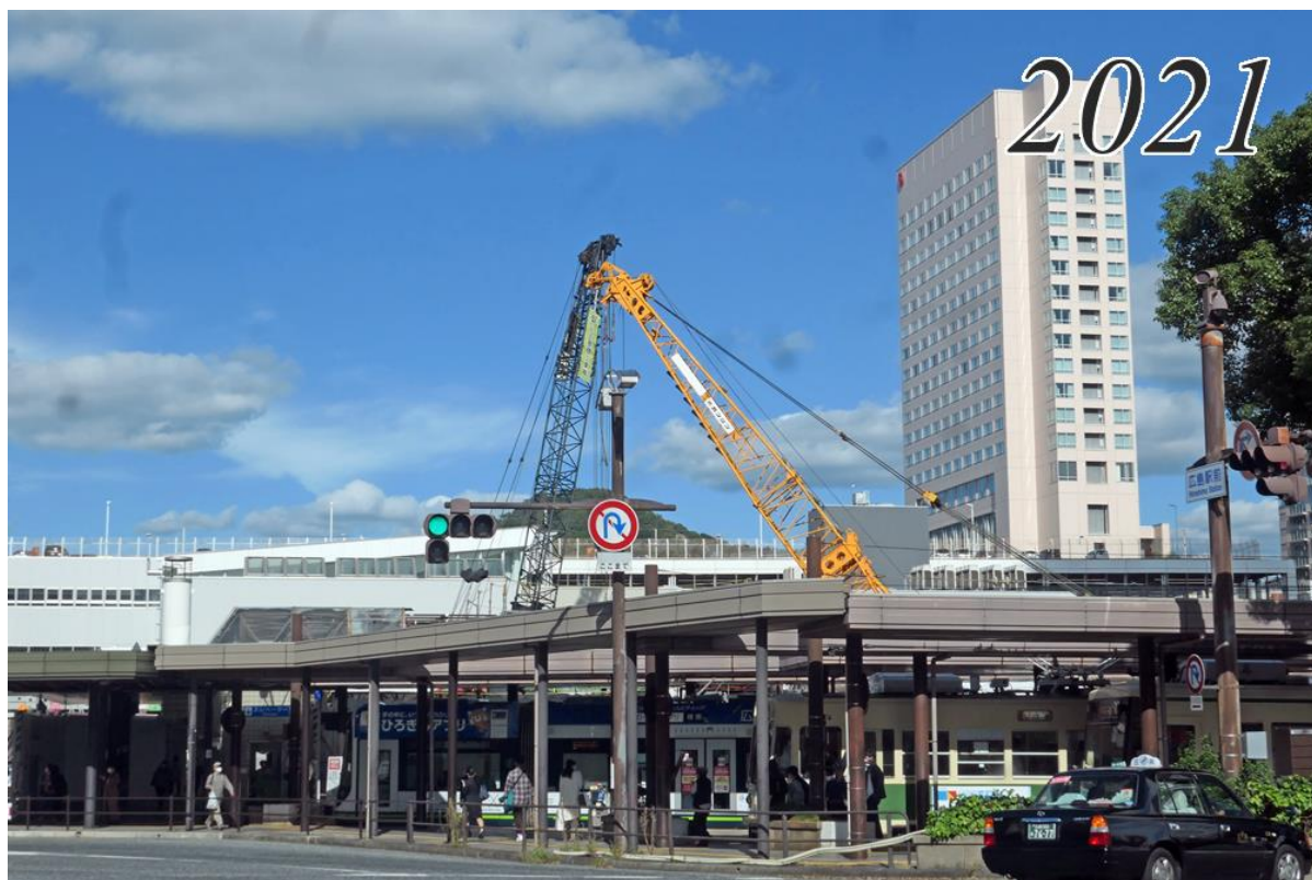
新駅ビルの建築工事が始まった
