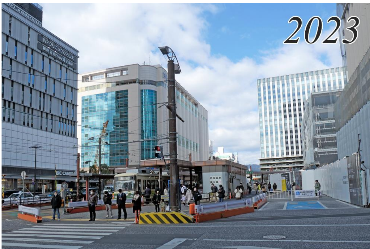
駅東側の仮横断歩道
