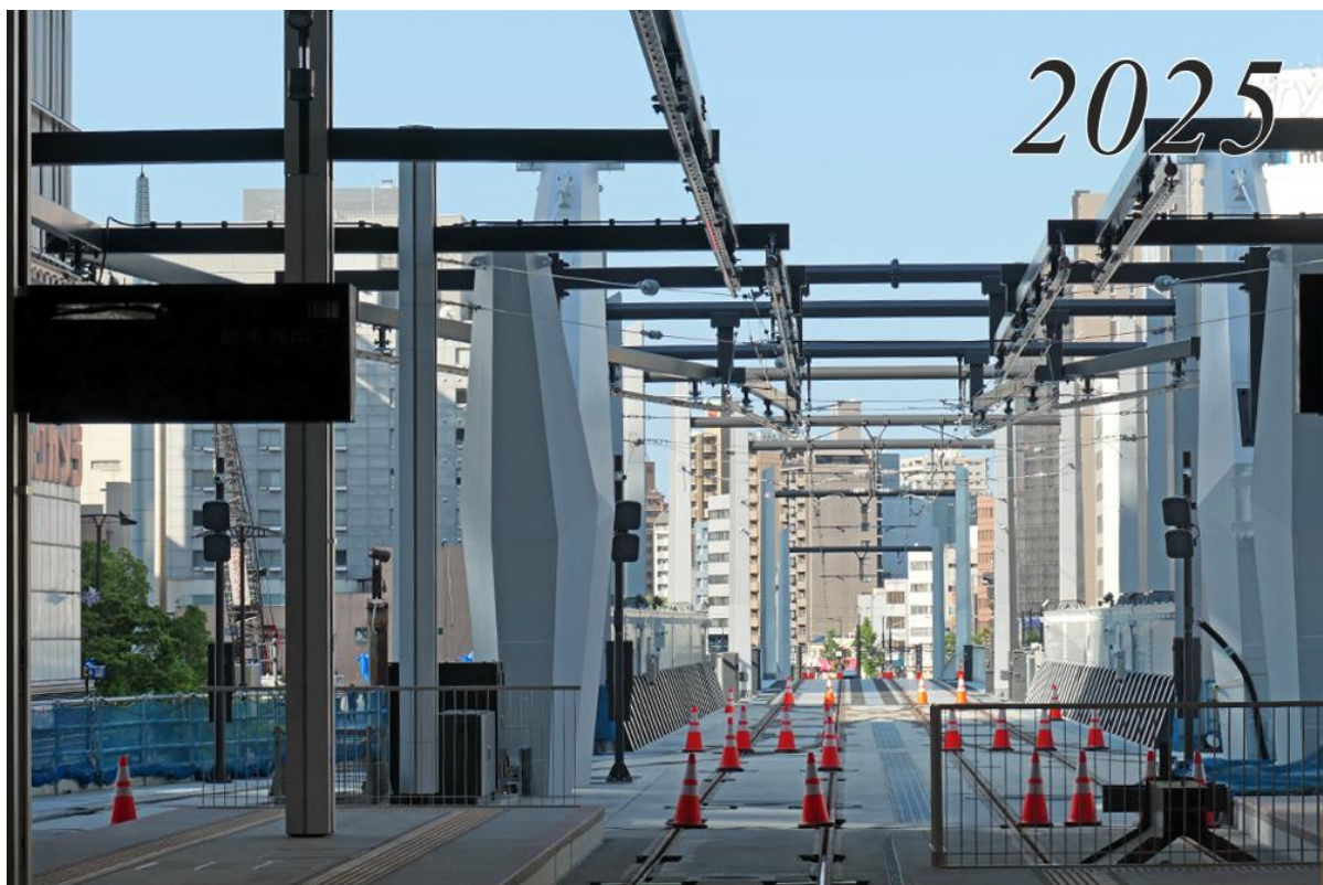
新しい路面電車ホームから駅前大橋方向を写す
