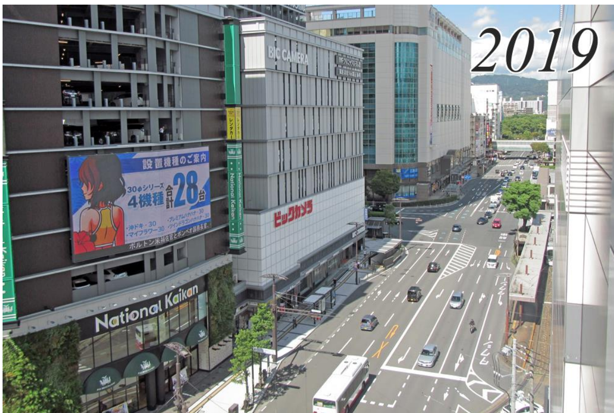
再開発Cブロック「エキシティ・ヒロシマ」から駅前交差点方向を写す
