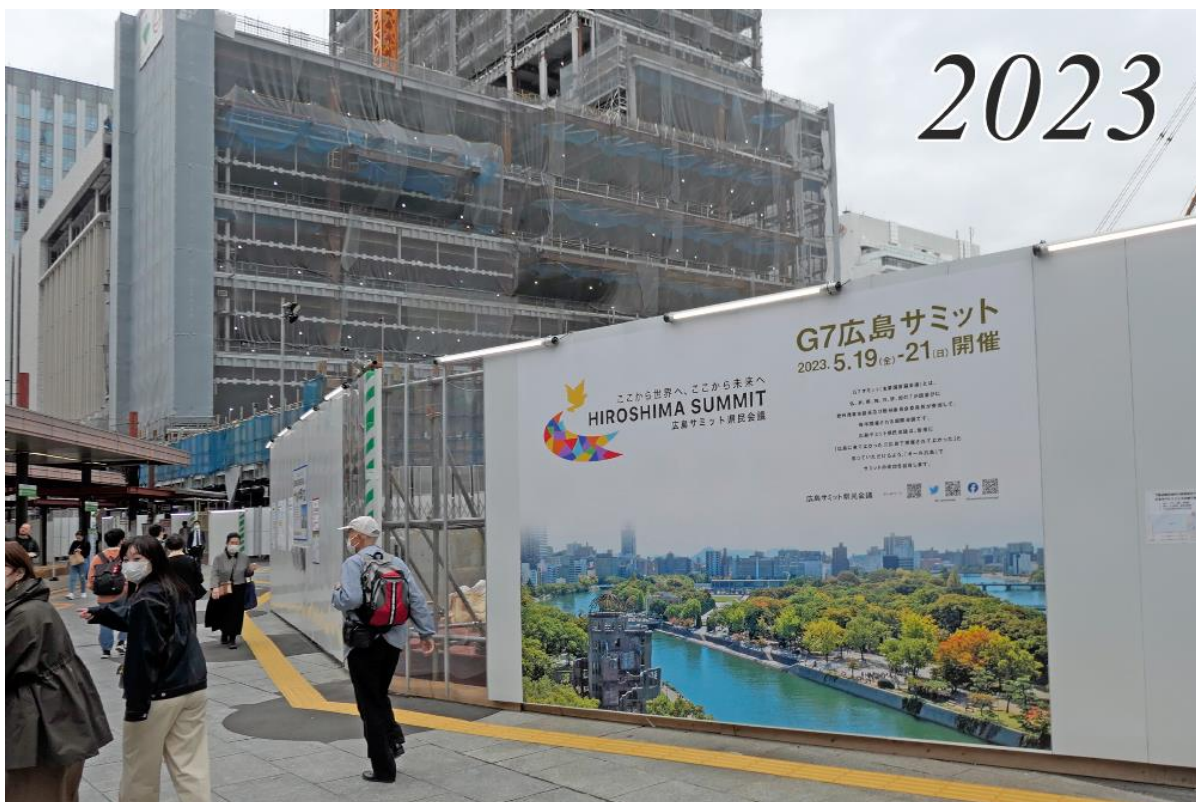
奥が駅ビル西側部分
