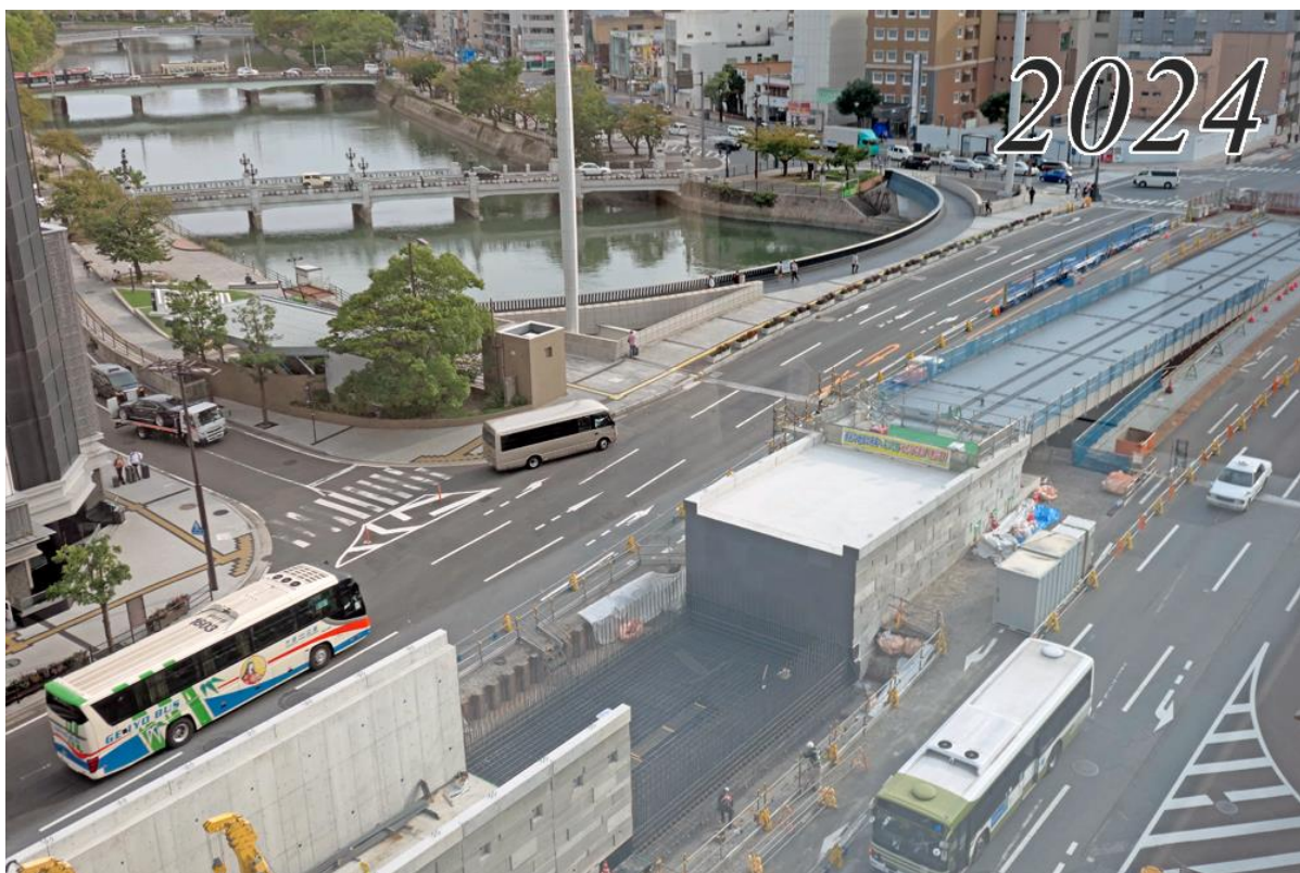
高架部の路盤には発泡スチロールブロックが敷かれる
