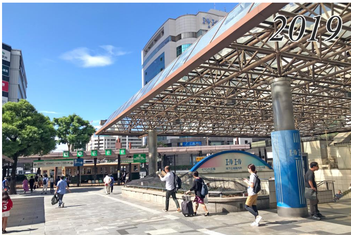
地下広場入口の大屋根
