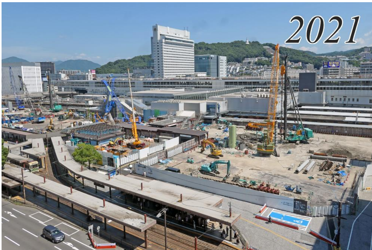
新駅ビルの建築工事が始まった
