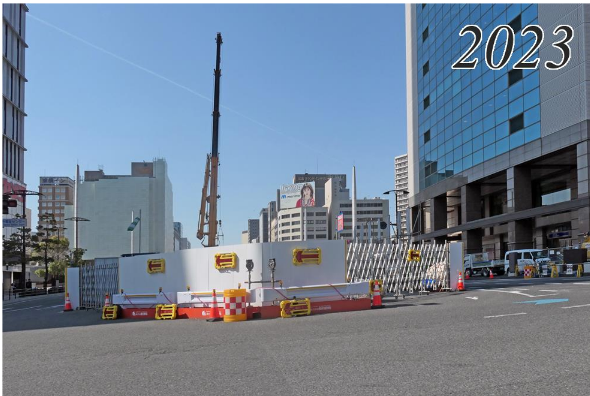
中央が路面電車軌道になる場所
