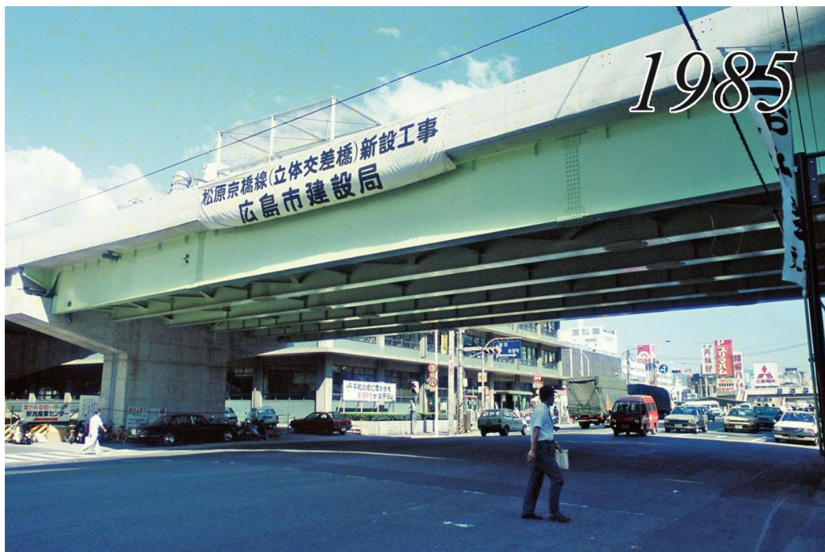
駅西高架橋が建設中だった
