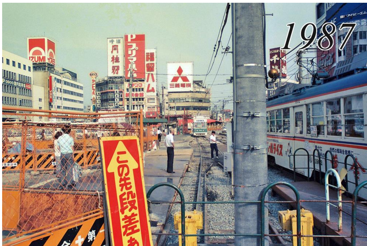
路面電車のりばでは3本目の折り返し線路が建設中だった
