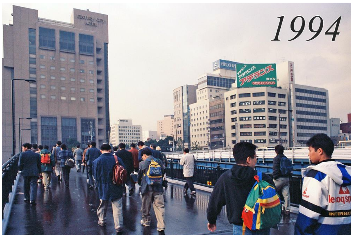
駅前大橋工事に伴う歩行者用仮橋
