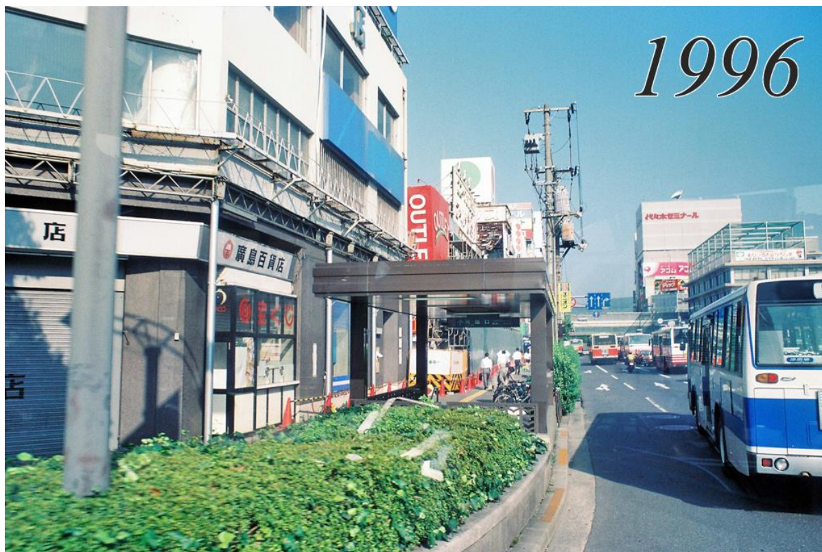
建物解体が近づいた駅前再開発Aブロック
