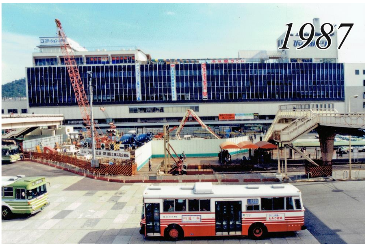
歩道橋の解体が進んでいた
