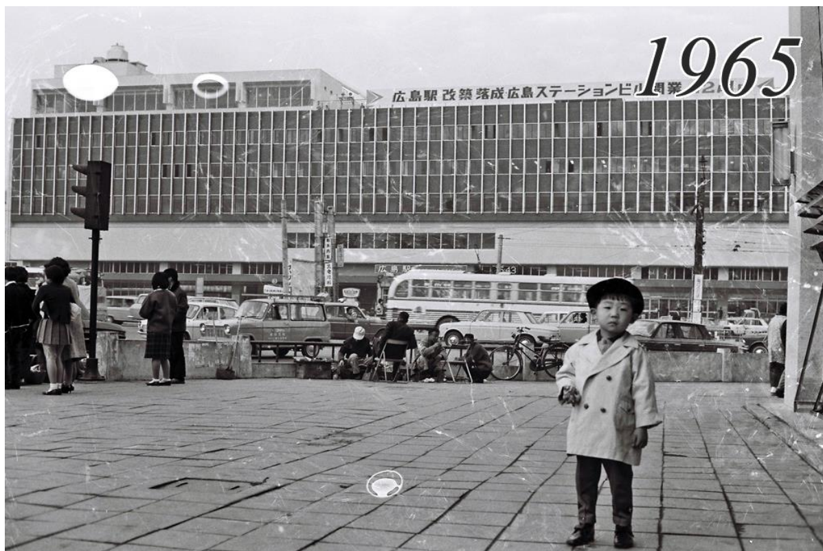
歩道橋ができる前。信号機の位置に横断歩道があった
