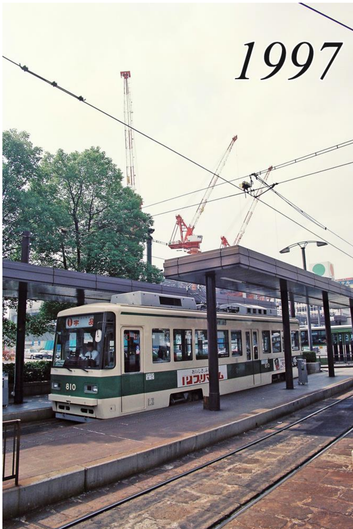
奥が建設中のエールエールA館
