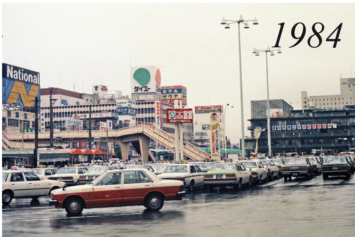
タクシープールから西側を写す
