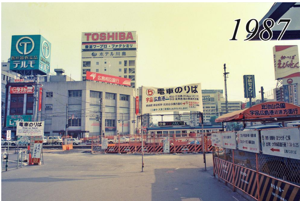
歩道橋の解体が終わった
